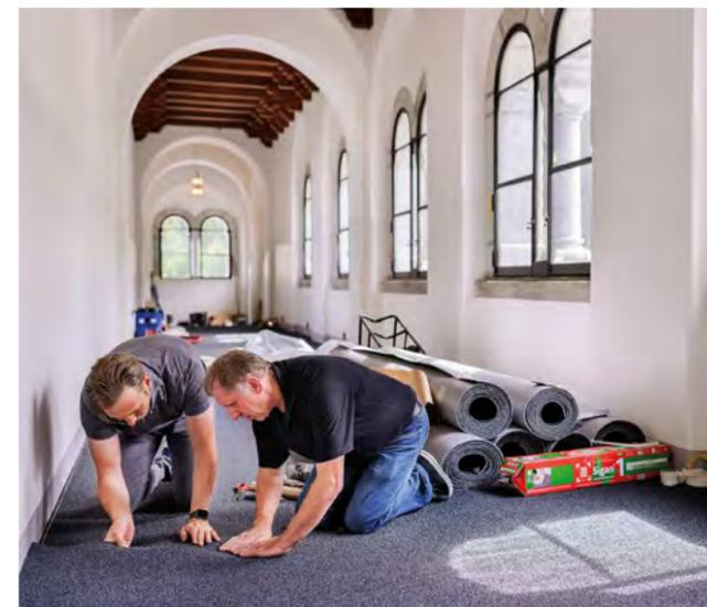
Um den historischen Boden optimal zu schützen, entschied man sich für einen Bodenaufbau mit Entkopplungsmatte und Edelstahlblech.
