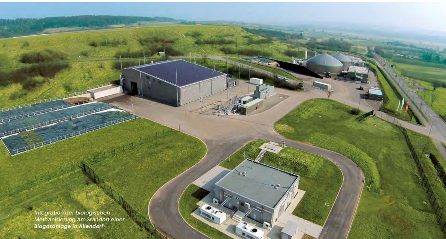
Integration der biologischen Methanisierung am Standort einer Biogasanlage in Allendorf
