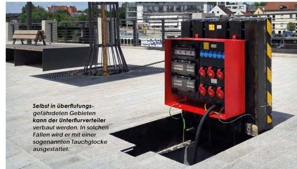
Selbst in überflutungsgefährdeten Gebieten kann der Unterflurverteiler verbaut werden. In solchen Fällen wird er mit einer sogenannten Tauchglocke ausgestattet.
