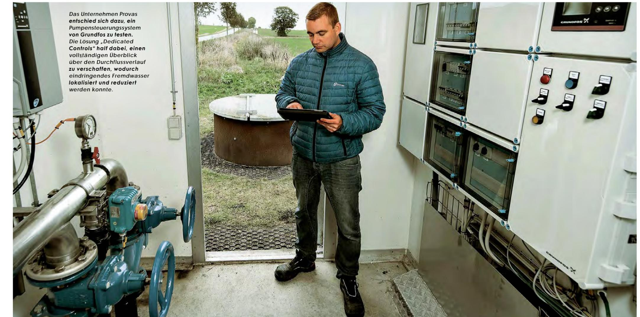
Das Unternehmen Provas entschied sich dazu, ein Pumpensteuerungssystem von Grundfos zu testen. Die Lösung „Dedicated Controls“ half dabei, einen vollständigen Überblick über den Durchflussverlauf zu verschaffen, wodurch eindringendes Fremdwasser lokalisiert und reduziert werden konnte.
