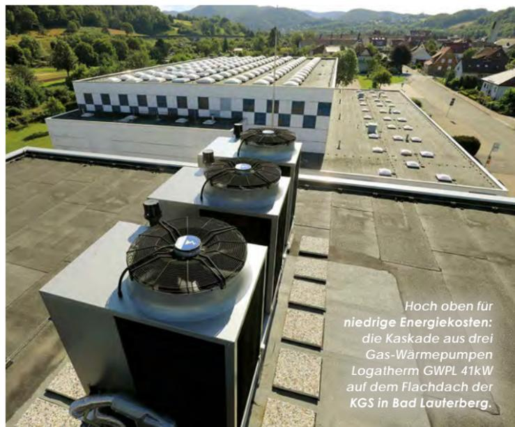
Hoch oben für niedrige Energiekosten: die Kaskade aus drei Gas-Wärmepumpen Logatherm GWPL 41kW auf dem Flachdach der KGS in Bad Lauterberg.
