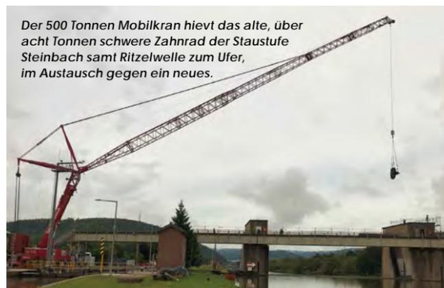
Der 500 Tonnen Mobilkran hievt das alte, über acht Tonnen schwere Zahnrad der Staufufe Steinbach samt Ritzelwelle zum Ufer, im Austausch gegen ein neues.
