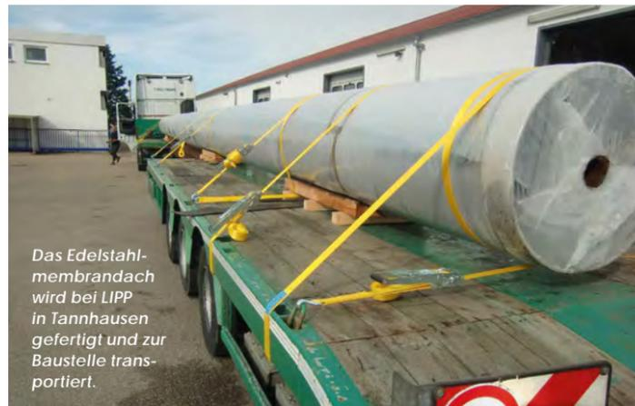
Das Edelstahlmembrandach wird bei LIPP in Tannhausen gefertigt und zur Baustelle transportiert.
