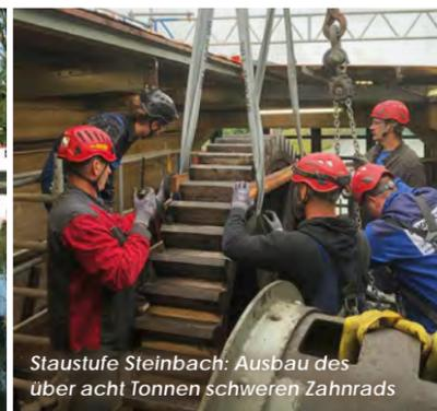
Staufufe Steinbach: Ausbau des über acht Tonnen schweren Zahnrads
