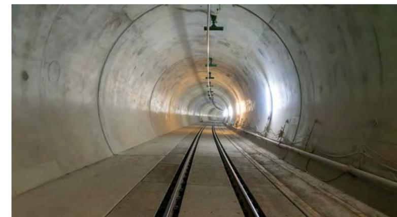
Die Makrofaser Concris ES von Fabrino kommt beim DB-Projekt Stuttgart/Ulm in Tunneln zum Einsatz und macht über 50 Prozent des Streckennetzes aus.
