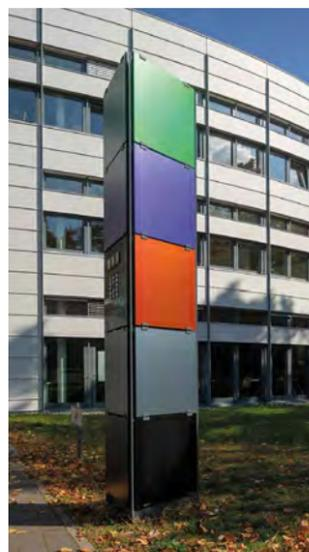
Pilotinstallation von MorphoColor-Farbschichten in der BIPV-Demonstrations-Steile vor dem Hauptgebäude des Fraunhofer ISE in Freiburg: PV-Module müssen architektonisch gestaltbar sein, um die Anforderungen an das Stadtbild und die Architektur des Gebäudes zu erfüllen.
