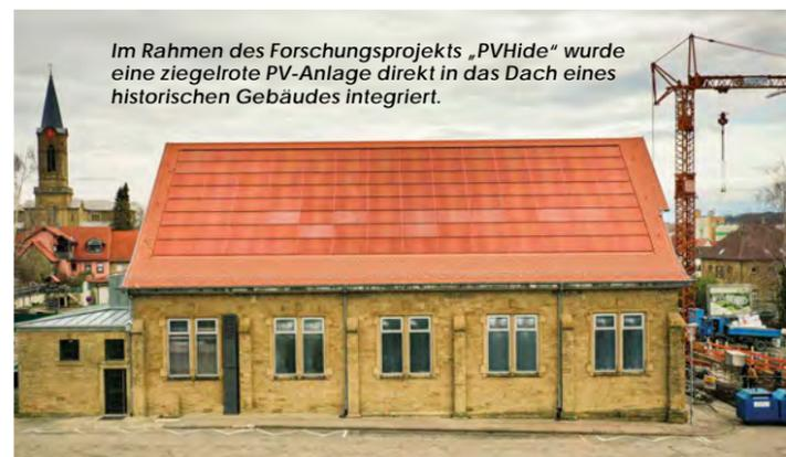
Im Rahmen des Forschungsprojekts „PVHide“ wurde eine ziegelrote PV-Anlage direkt in das Dach eines historischen Gebäudes integriert.
