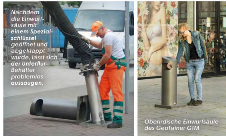
Nachdem die Einwurfsäule mit einem Spezialschlüssel geöffnet und abgeklappt wurde, lässt sich der Unterflur-Behälter problemlos aussaugen.
