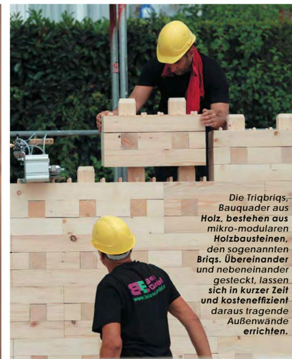
Die Triqbriqs, Bauquader aus Holz, bestehen aus mikro-modularen Holzbausteinen, den sogenannten Briqs. Übereinander und nebeneinander gesteckt, lassen sich in kurzer Zeit und kosteneffizient daraus tragende Außenwände errichten.
