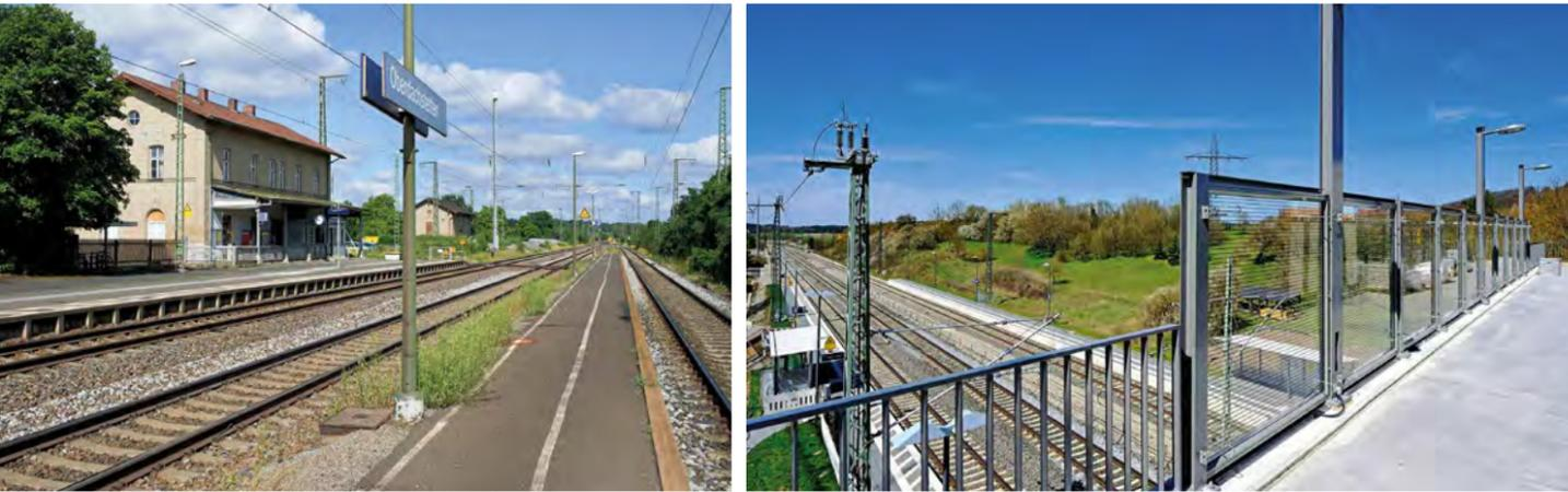
Links: Der alte, vernachlässigte Bahnhof Oberdachstetten (westlich von Nürnberg) im Juli 2017 in der Planungsphase vor dem barrierefreien Umbau. Rechts: Endlich barrierefrei ist der selbe Bahnhof vier Jahre später, im April 2021, kurz vor der endgültigen Fertigstellung des Umbaus. Dafür wurde eine Fußgängerüberführung mit Treppentürmen und Aufzügen sowie Zuwegungen an der Brücke über die Fränkische Rezat realisiert.
