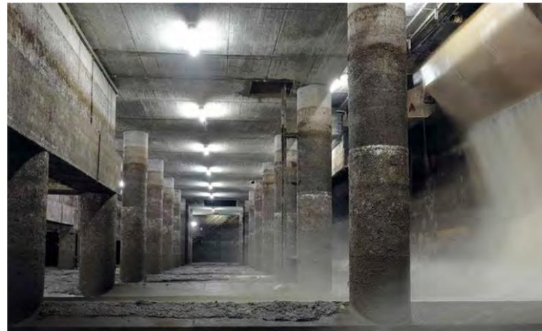
Regenwasserrückhalt im Neckar-Park in Stuttgart: Hier soll ein Großteil des Regenwassers gehalten werden und so die Grundwasserneubildung unterstützen und durch Verdunstung das Mikroklima verbessern.
