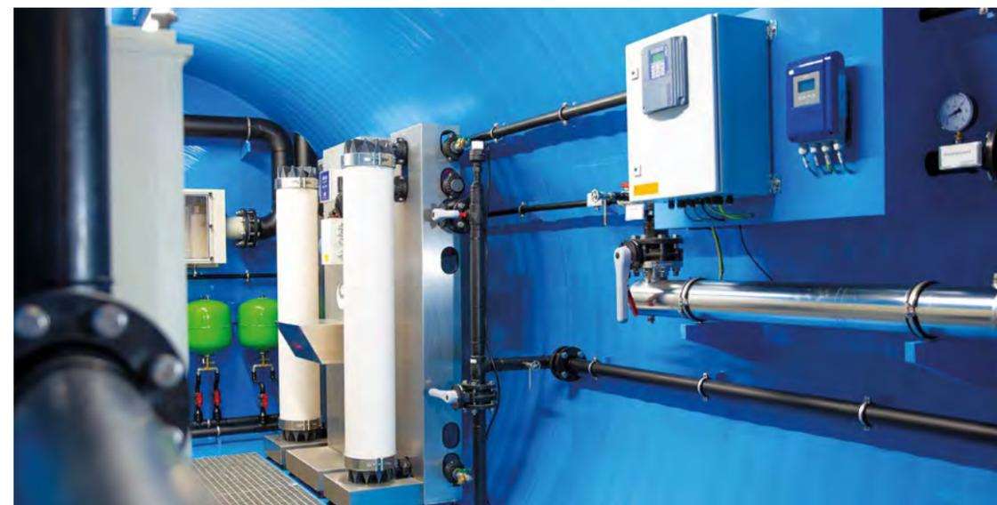
Die Phoenix 4 Ultrafiltration von Seccua (links hinten) und die bestehende UV-Anlage (rechts außen im Bild) bilden in Kirchberg im Bayerischen Wald eine wirkungsvolle Doppelbarriere gegen jegliche Trübungen. Dabei wird auch bei Extremwetterereignissen sichergestellt, dass die UV-Strahlung der Anlage zuverlässig wirken kann.
