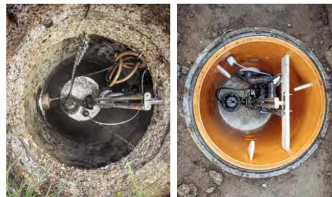
Links: Der marode Altschacht wird mit einem hochauflösenden Lasersystem vollständig gescannt. Rechts: Der selbsttragende, korrosionsfreie und dauerhaft dichte Schacht wird auf die Baustelle geliefert und kann sofort eingesetzt werden.
