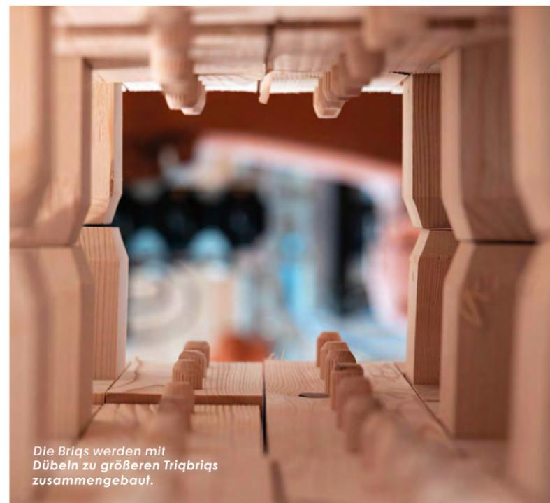
Die Briqs werden mit Dübeln zu größeren Triqbriqs zusammengebaut.
